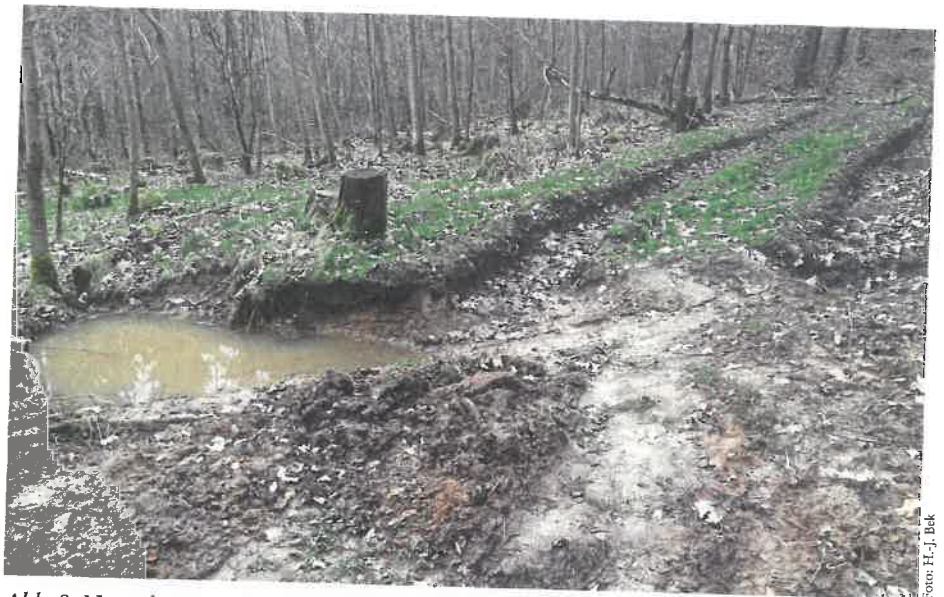
Abb. 8: Neuanlage im Zuge einer Maschinenwegsanierung
